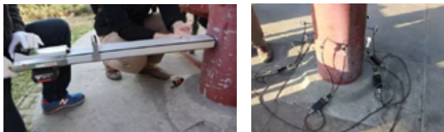
阻力仪与应力波仪对故宫木柱进行保存现状检测
